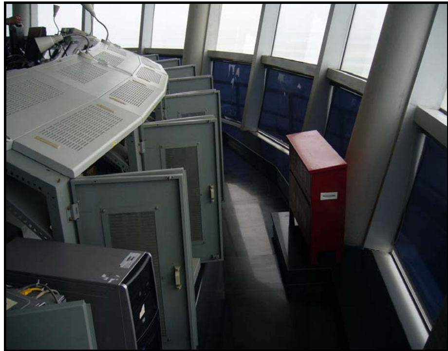
圖 26：浦東機場塔臺作業室裝備維修走道
