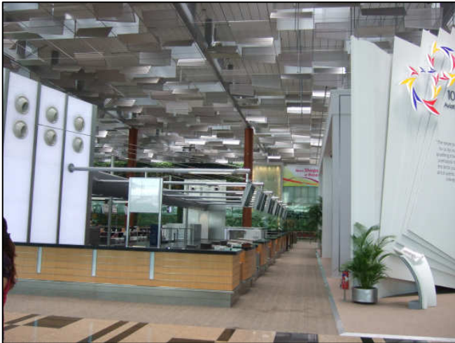
圖 12.1 航廈屋頂裝設日光照明系統
