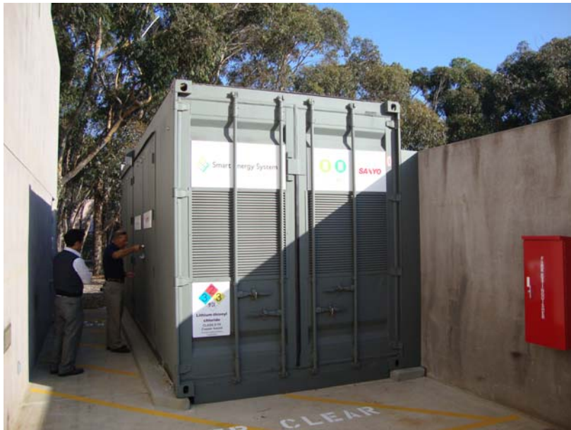
圖 19 30 kWh 鋰電池儲能系統。 (感謝 Mr. D. Weil 同意拍攝)
