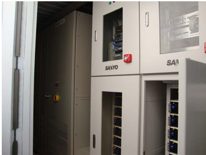
圖 20 30 kWh 鋰電池儲能系統。(內部) (感謝 Mr. D. Weil 同意拍攝)
