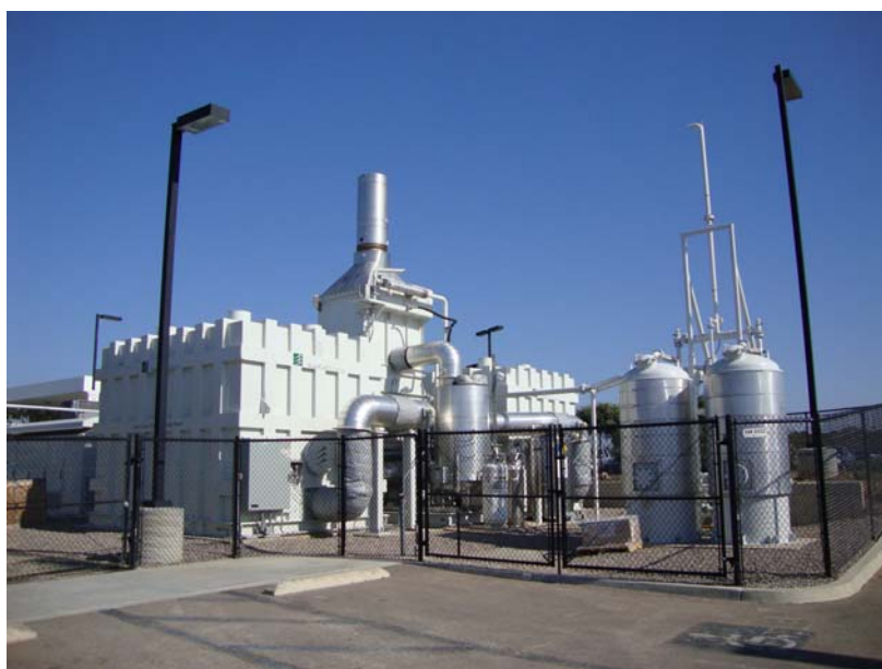
圖 16 2.8 MW 之 MCFC 發電站。(感謝 Mr. D. Weil 同意拍攝)
