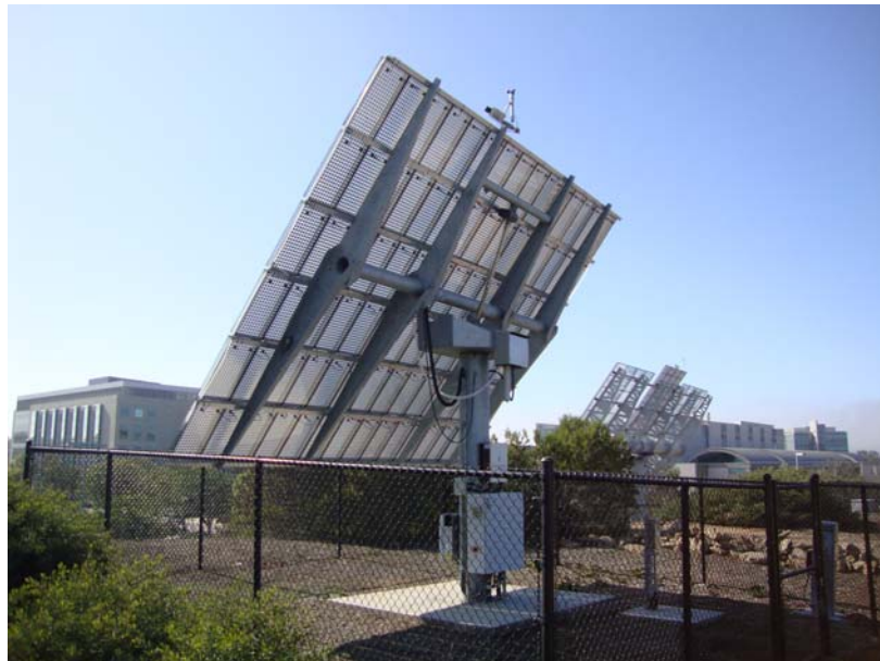
圖 17 聚光型太陽電池(CPV)發電站：6 kW(前)、22 kW(後)。 (感謝 Mr. D. Weil 同意拍攝)
