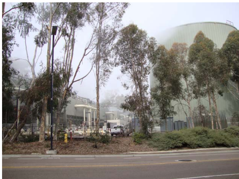
圖 21 熱能儲存設施(冷水槽(右)、熱交換塔(左))。 (感謝 Mr. D. Weil 同意拍攝)
