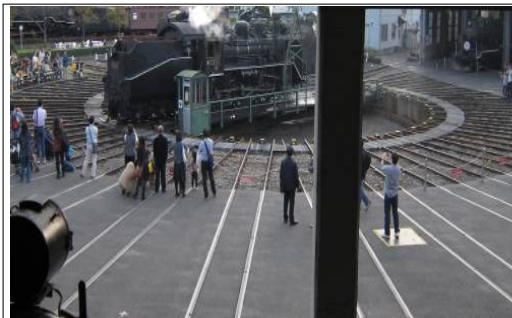
共有 20 組軌道，分別通達 20 個車庫，轉車台在放射中心點上，可操控旋轉讓各線火車頭轉到要進站補給或維修之車庫之軌道上。
