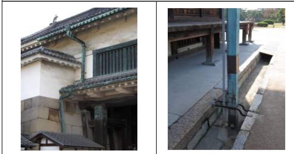
天溝與漏水管完全遵古修復，保留原汁原味
