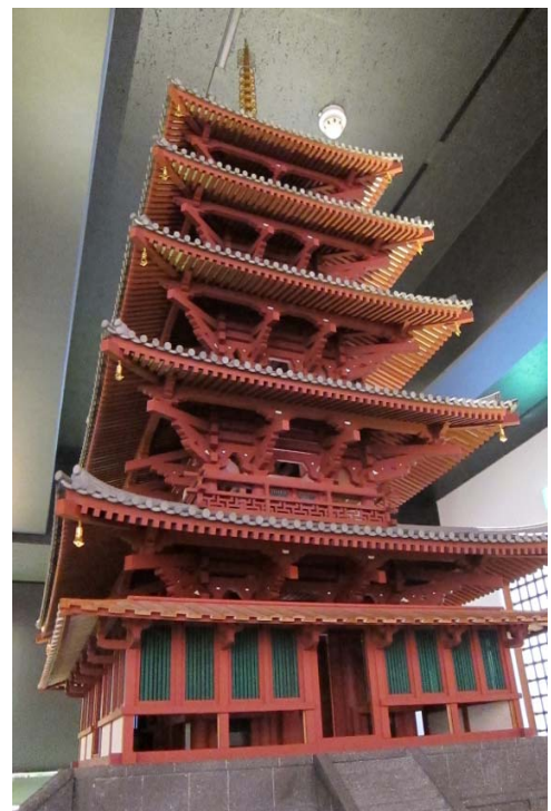
法隆寺五重塔模型。左：僅有骨架，全部榫接組裝。右：加上懸檐裝飾、屋頂瓦片、牆壁及門窗等之完整建築。
