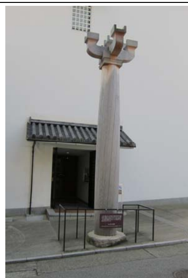
館入口處矗立著一根巨大的木柱，它是世界最古老的木造建築—法隆寺金堂入口側柱的實物模擬，其頂端有皿斗型式的大斗。當時是西元七世紀，大木工匠的技術就已經如此高超。
