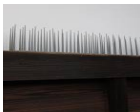
爲防止鳥類棲息，以類似鐵釘的針狀鐵線黏貼在橫向構件上，形成防止鳥踏。
