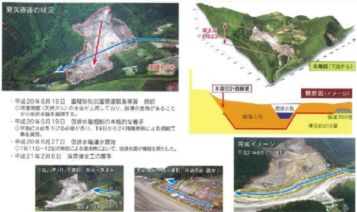
圖 17 宮城縣一迫川小川原地區大規模崩塌及堰塞湖災情概況。
