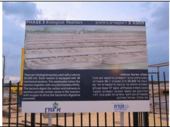
Shafdan 廢水處理廠
