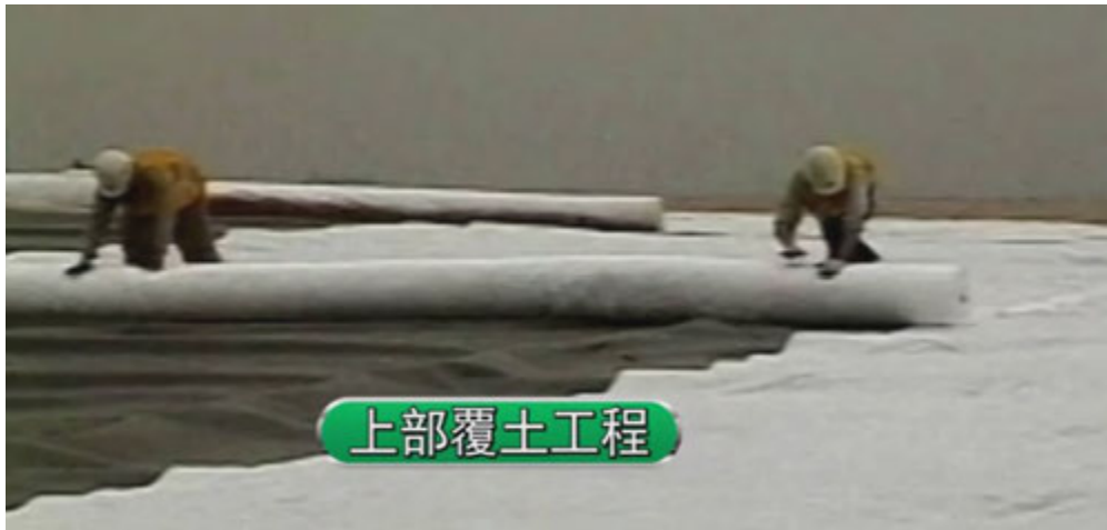
圖 7 頂部覆土工程
