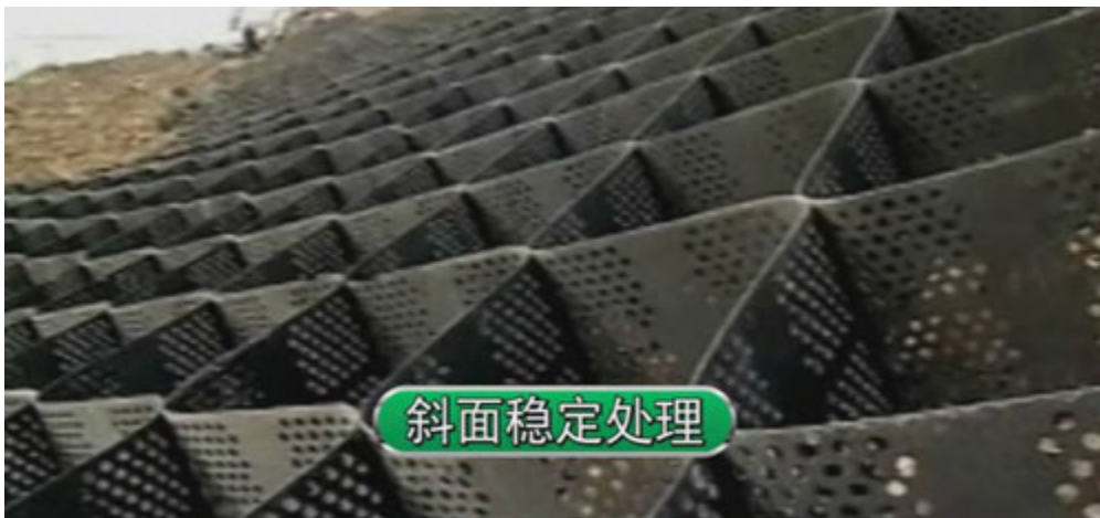
圖 8 坡面穩定工程
