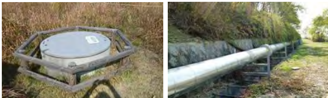
圖 9 沼氣收集井及輸送管線
