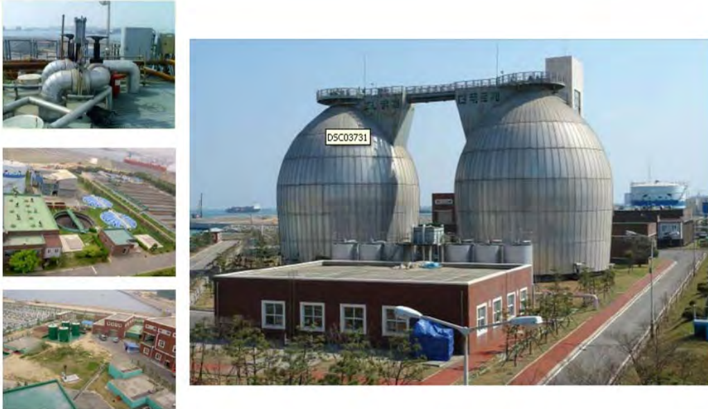
圖 26 龍淵污水處理廠廠區照片
