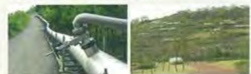
填埋废气处理及再活用
