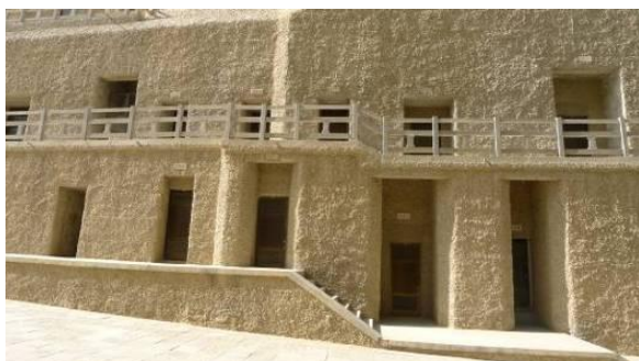
圖 59：莫高窟外壁表面以灰泥漿整修
