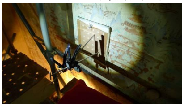
圖 65：壁畫脫鹽設備
