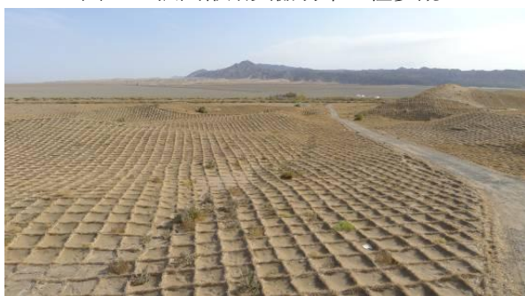
圖 69：防砂工程進行區域
