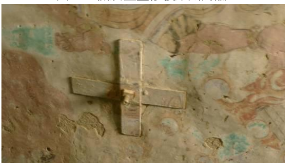
圖 66：壁體結構性加固技法
