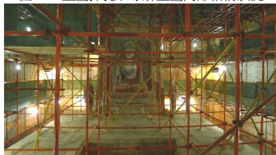
圖 80：修復現場搭設之工作鷹架
