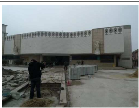
入口廣場正進行整修工程
