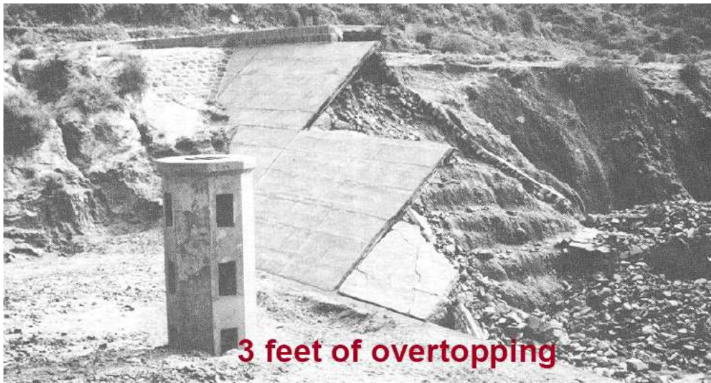
Frias 壩潰口處照片
