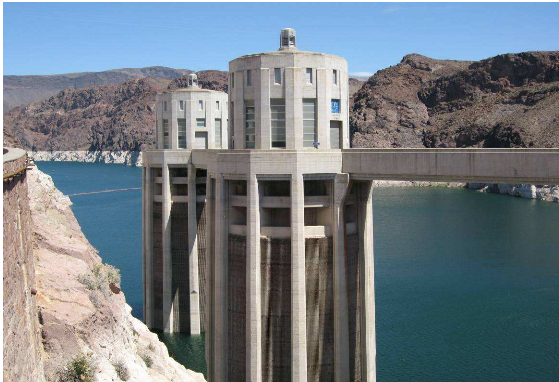
Hoover 壩取水塔
