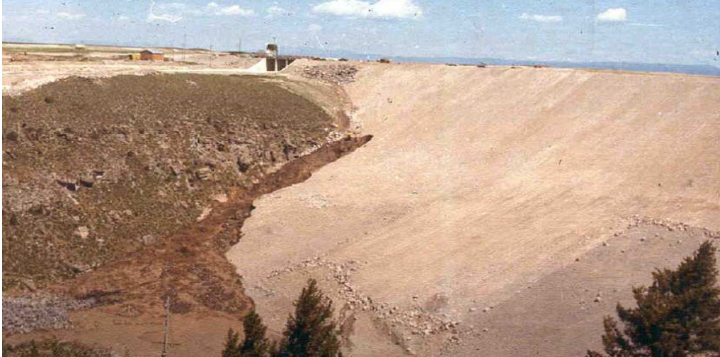
Teton 壩初期管湧情形
