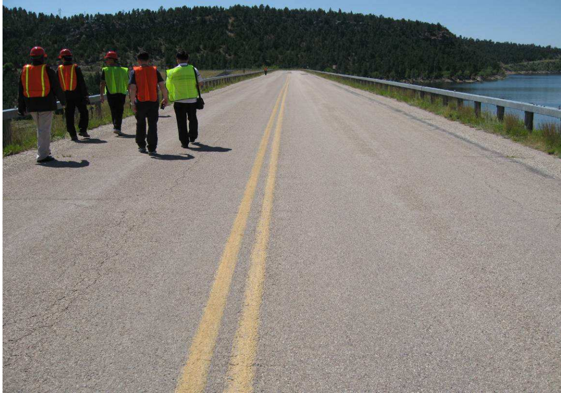
Glendo 壩壩頂照片(瀝青路面有些許龜裂與修補痕跡)
