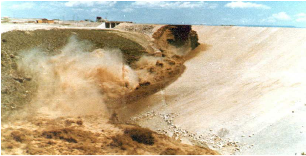
Teton 壩破壞程度持續擴大
