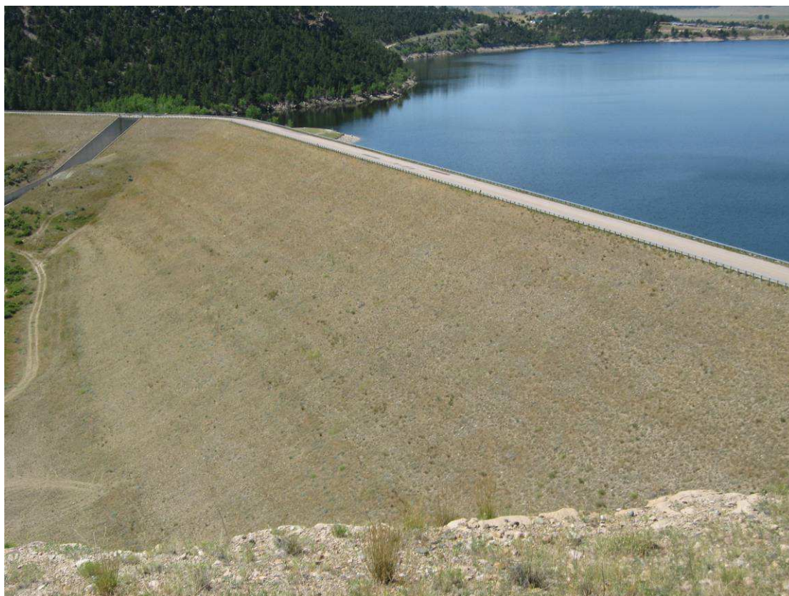
Glendo 壩下游壩面
