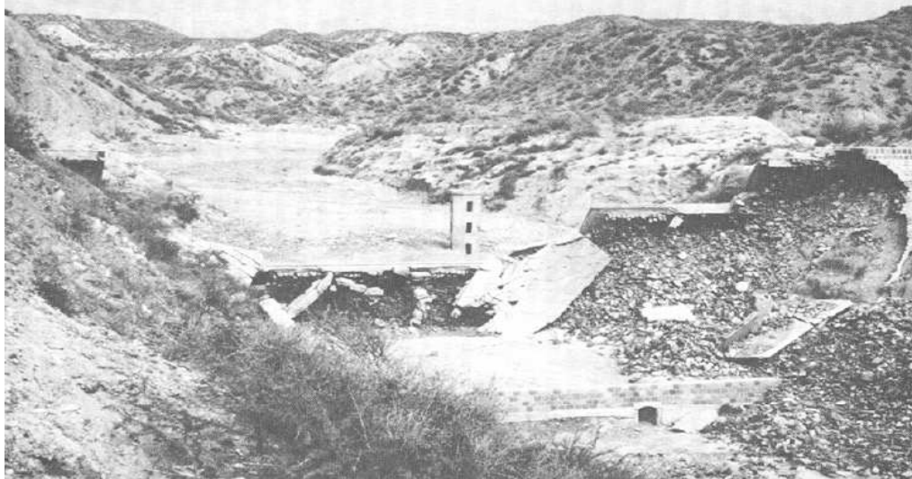
Frias 壩潰壩後照片
