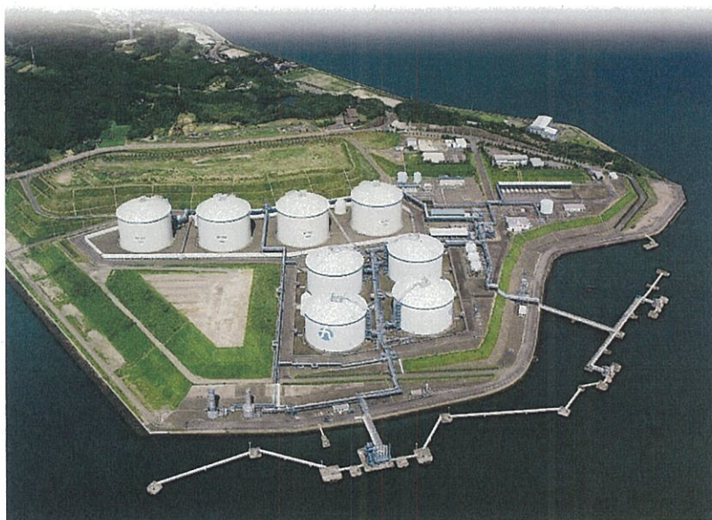
圖 5 LPG 接收站及儲槽
