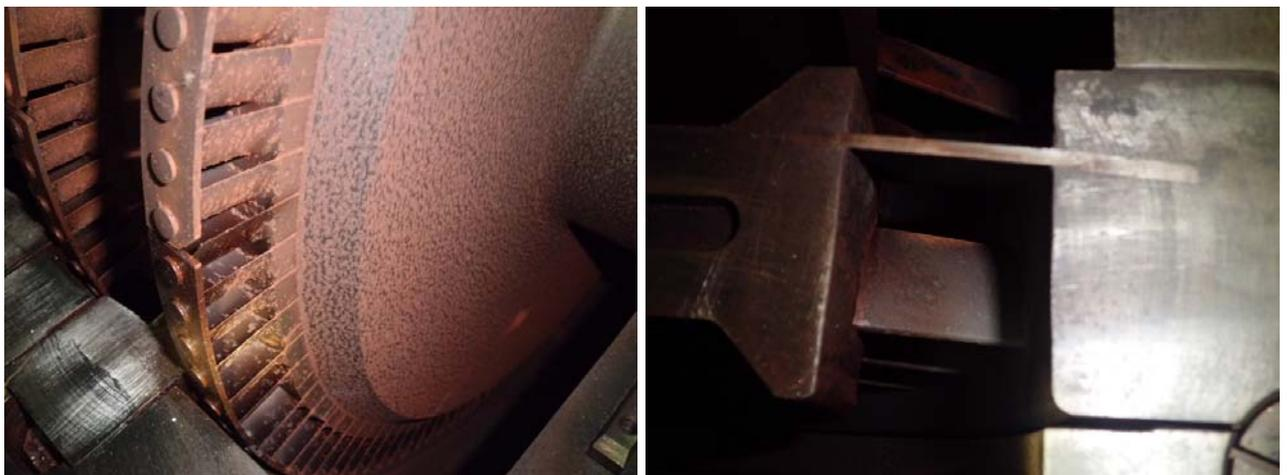
還有 Super heater Header 也發現有水垢之產生，因此懷疑鍋爐之蒸汽品質似乎有水分攜帶之問題存在，建議應從加強鍋爐爐水排放，徹底依照規定完成
