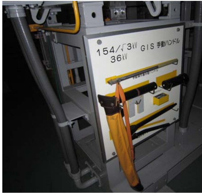
圖 25 GIS 手動操作工具
