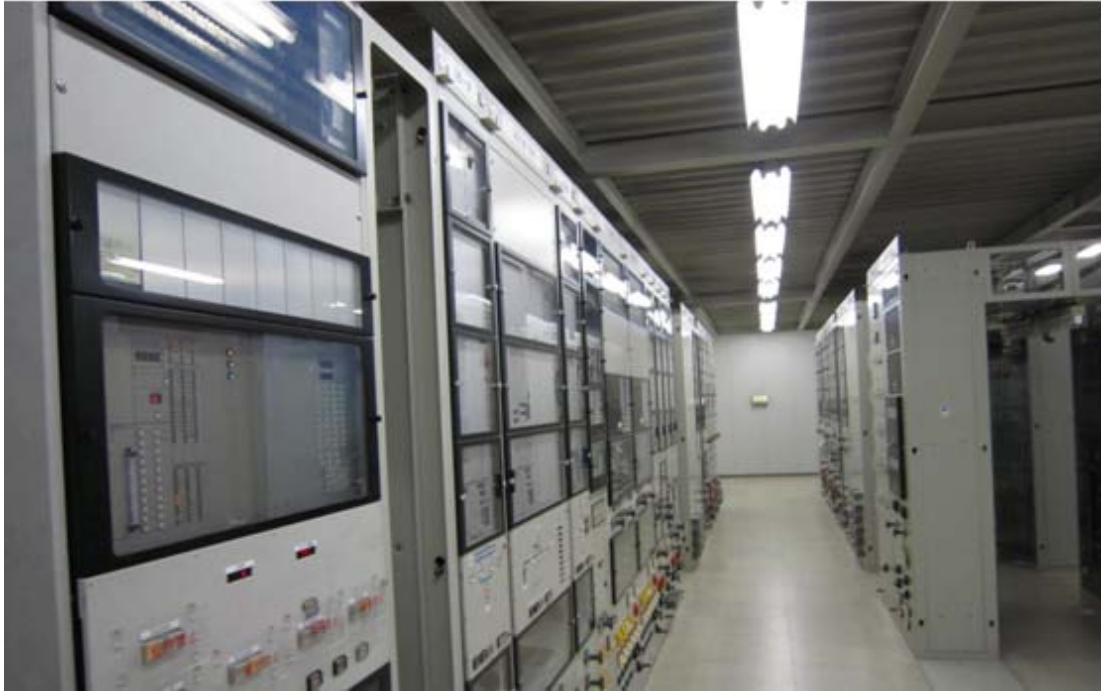
圖 28 控制室內之天花板
