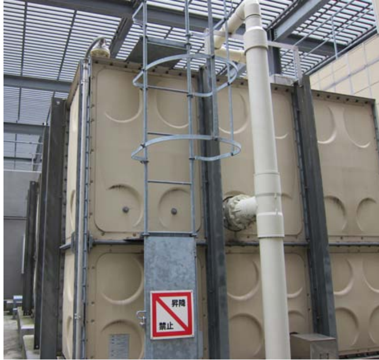
圖 29 冷卻水塔外殼包覆
