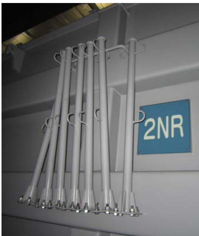
圖 24 電抗器外箱之高處作業支撐桿
