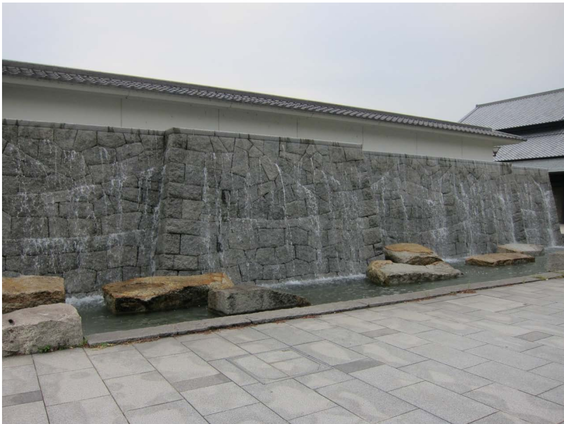
圖 30 冷卻水透過瀑布牆散熱
