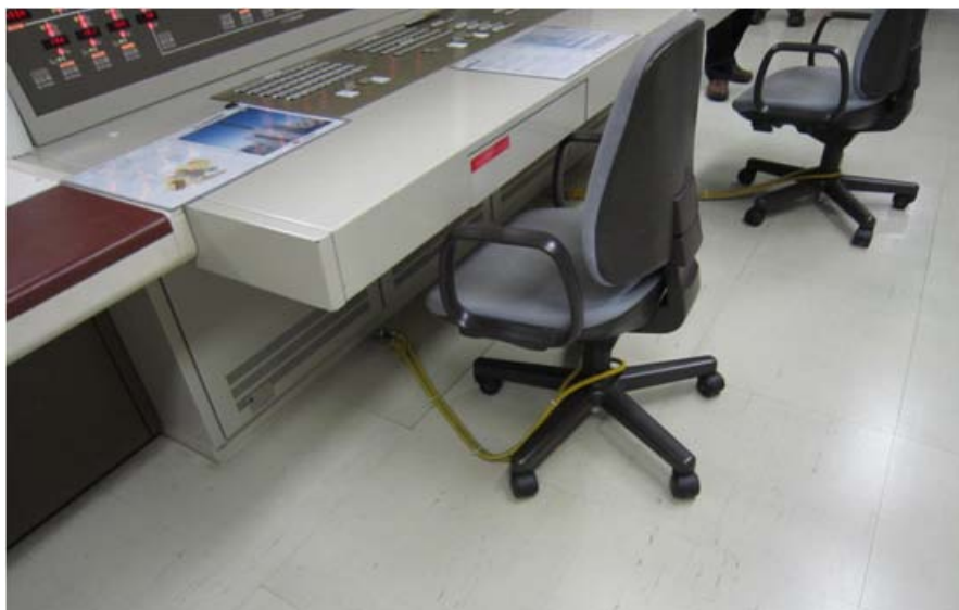
圖 19 控制室內座椅固定
