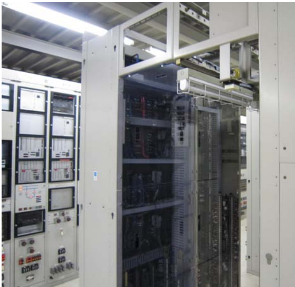
圖 27 控制盤及電驛盤採無頂蓋之設計
