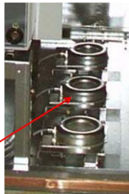
圖5電子式比流器裝設於中壓GIS案例（資料來源：ABB公司）
