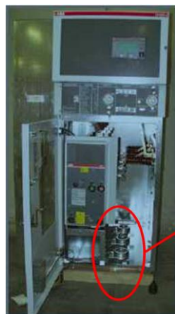
圖5電子式比流器裝設於中壓GIS案例（資料來源：ABB公司）
