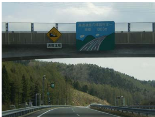
圖 20 高速公路概況 資料來源： http://ja.wikipedia.org/wiki/%E3%83%95%E3%82%A1%E3%82%A4%E3%83%AB:TokaiI-Hokuriku_Expressway.jpg
