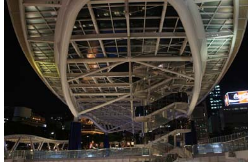
圖 10 車站周邊地區開發概況 2 資料來源：自行拍攝
