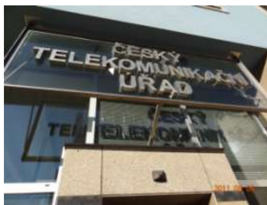
圖表 6 捷克電信辦公室大樓。
