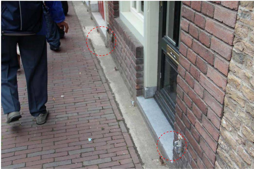
圖 47 房子背水面小型擋水板固定槽構造圖
