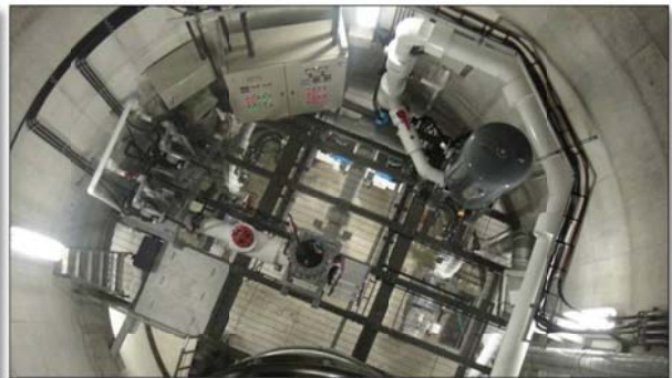
自地面入口處俯瞰 13 公尺下之取水設施
