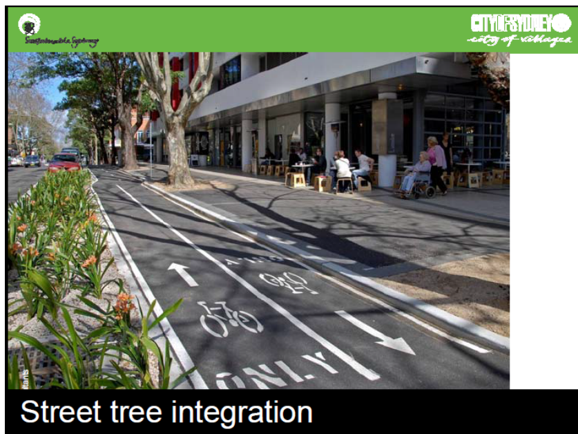
圖 3.38 分隔式自行車專用道與路樹的整合設計
