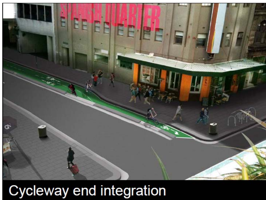
圖 3.36 雪梨分隔式雙向自行車專用道路口寬度不足的佈設 資料來源：Adam Fowler, “Delivering cycleways: the challenges of separation and retrofit in the City of Sydney”, APCC, 2011.11.18.
