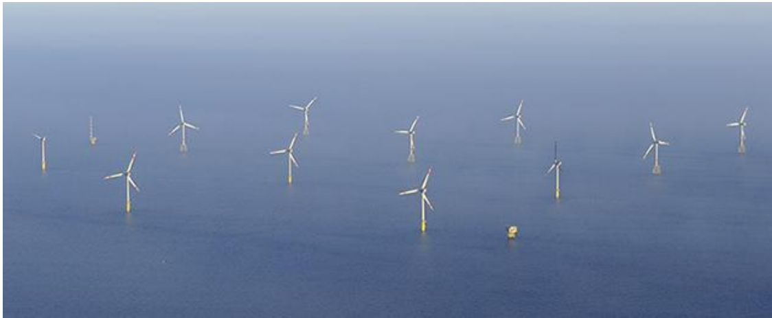
圖十二、由 12 部 5MW 風機組成的德國第一個離岸風場 Alpha Ventus (source: http://www.alpha-ventus.de/ )
