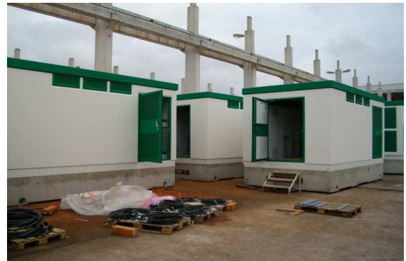
圖 1-14 Inverter 組裝過程
