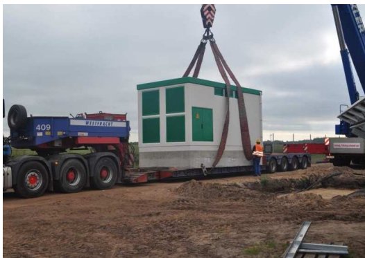
圖 1-15 Inverter 吊運至定位
