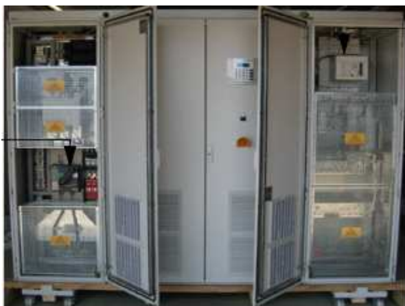
圖 1-17 Xantrex Inverter GT630E
