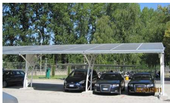
圖 2-10 停車棚太陽光電系統-2
