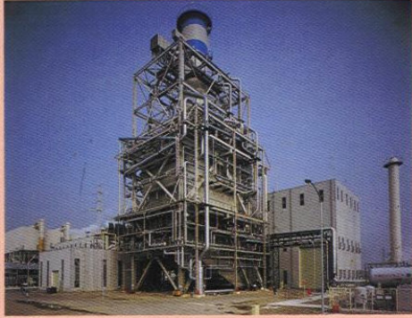
圖 31、T-point 示範電廠的廢熱回收蒸氣產生器和除氮器
