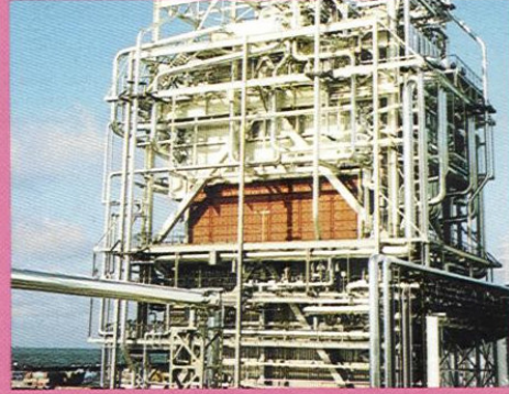
圖 31、T-point 示範電廠的廢熱回收蒸氣產生器和除氮器
