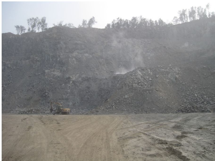
圖九 江蘇六合開挖玄武岩現場，塵土飛揚。
