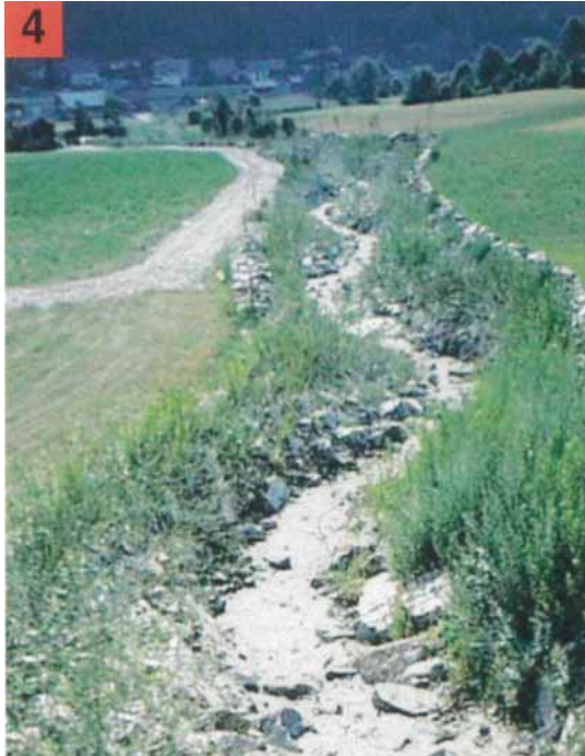
照片 05 放流之河道原狀與加寬加固保護施工中 (Prof Heumadar 提供)
