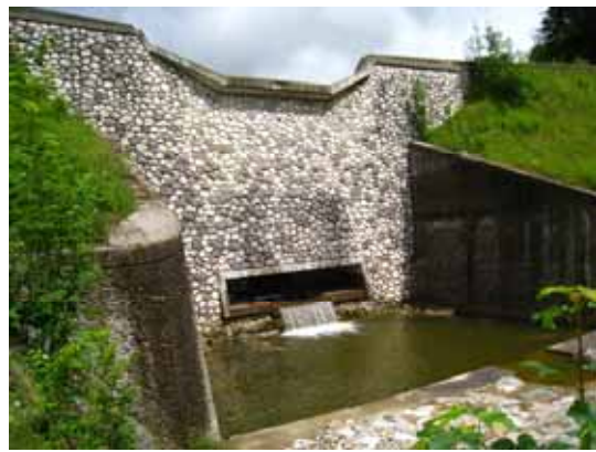
滯洪池下游防沖刷翼牆及護檻構物
