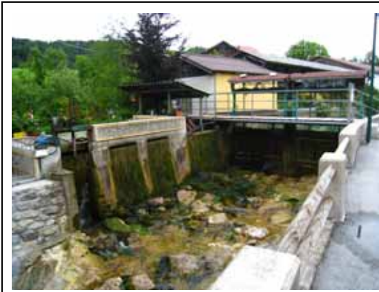
Ebenau 鎮私人小型水力發電廠共 二組機組其調節池出口
