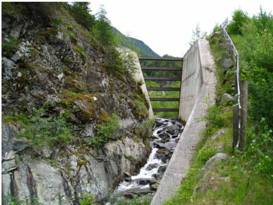
照片 09 為安全考量重要部分仍採用混凝土構物
