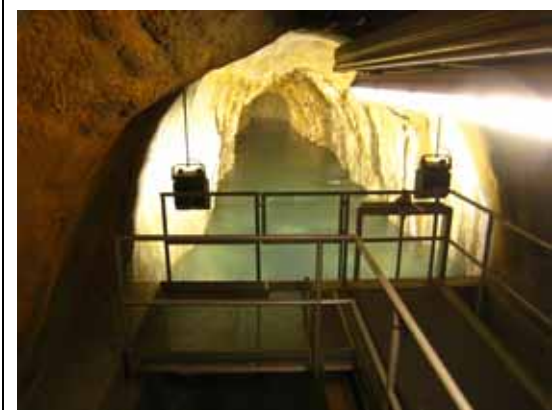
以隧道技術深入山脈底層引取純淨深層地下水供給民生用水，毋須額外再處理同時水源穩定
