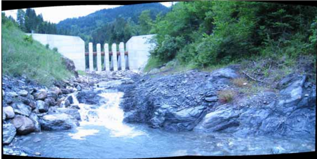
照片 01 土石流先經過 Breaking Dam 消能 (經接圖處理)
