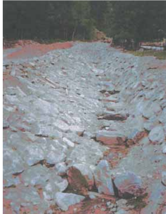
照片 05 放流之河道原狀與加寬加固保護施工中 (Prof Heumadar 提供)
