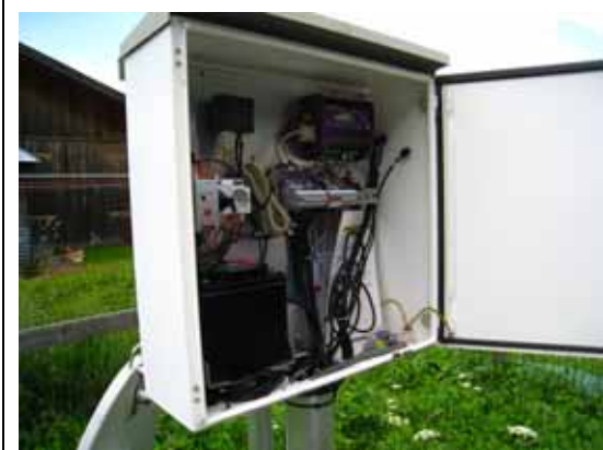
逕流預測之全自動觀測站，完整預測模式所需用到參數皆有相對應觀測儀器提供即時數據
