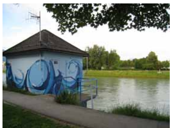
Salbach 流量水位量測站
