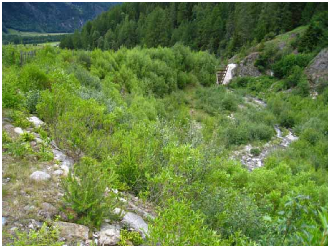
照片 04 山洪及土石流蓄滯池 2011 年現況
