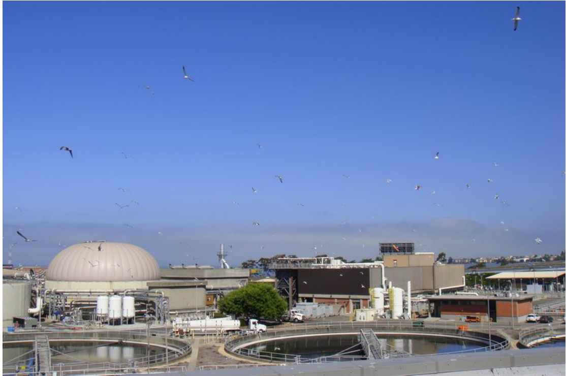
圖左下米白色圓頂建築物，為北加州客家同鄉會陳前會長宗男於1977年設計的離心器，主要將污水中的水和固體分離。
