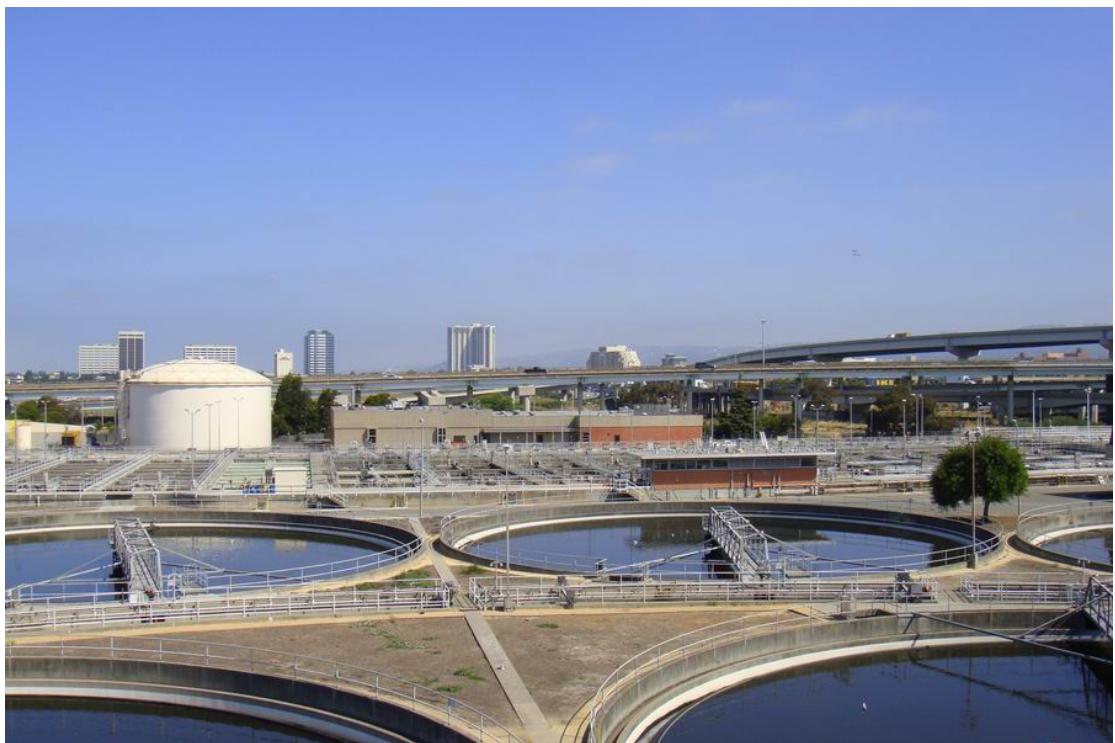
圓形池為污水二級處理—「生物處理」，讓有機物將污水中的微生物分解淨化。
