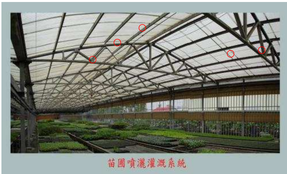
照片 2 苗圃噴灑灌溉系統(設置於上方：紅色圈位置)
