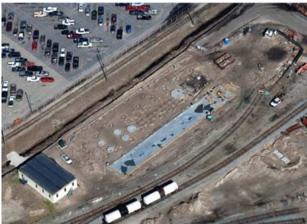
圖 3-2 位於佛州 Perry 建設中的生質燃料生產工場
