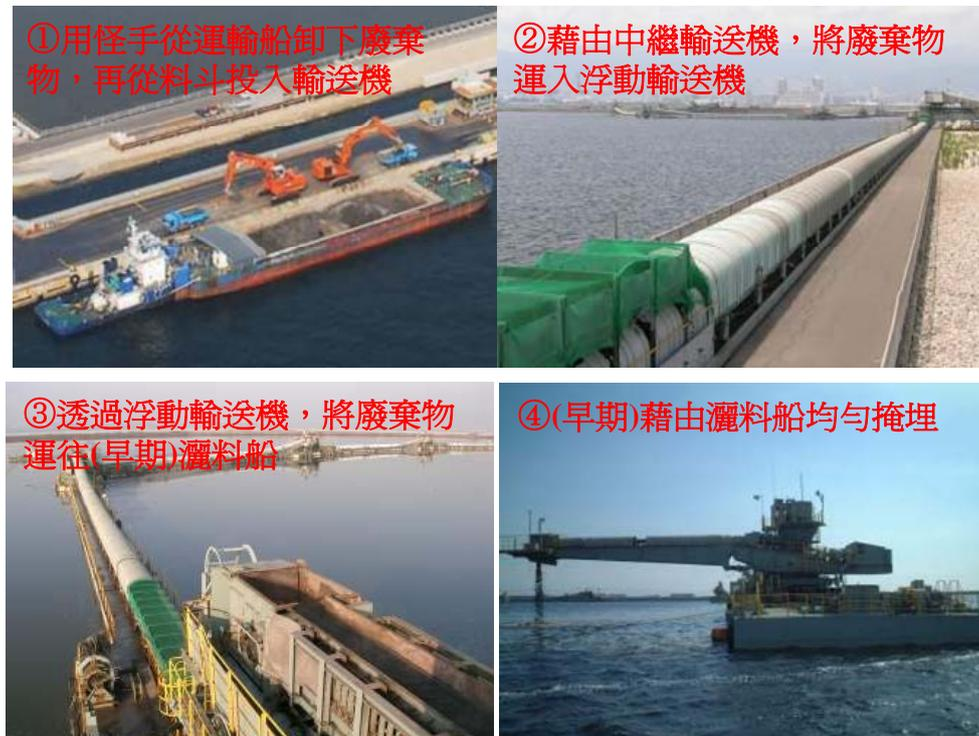
圖 3-10 藉由輸送帶及灑料船進行填埋作業
