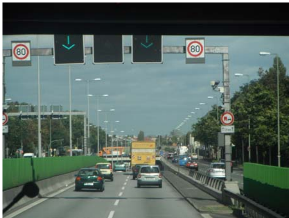
圖69 高速公路可變式車道管制號誌
