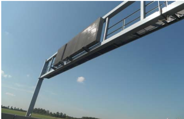
圖71 高速公路資訊可變標誌（門架輕巧）
