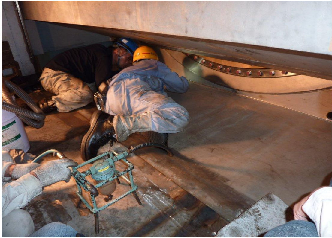
7/25 No.2 射流閘門試漏-以吸水器收集漏水量，測試結果 14.2CC/分 << 標準 175CC/分，結果符合
