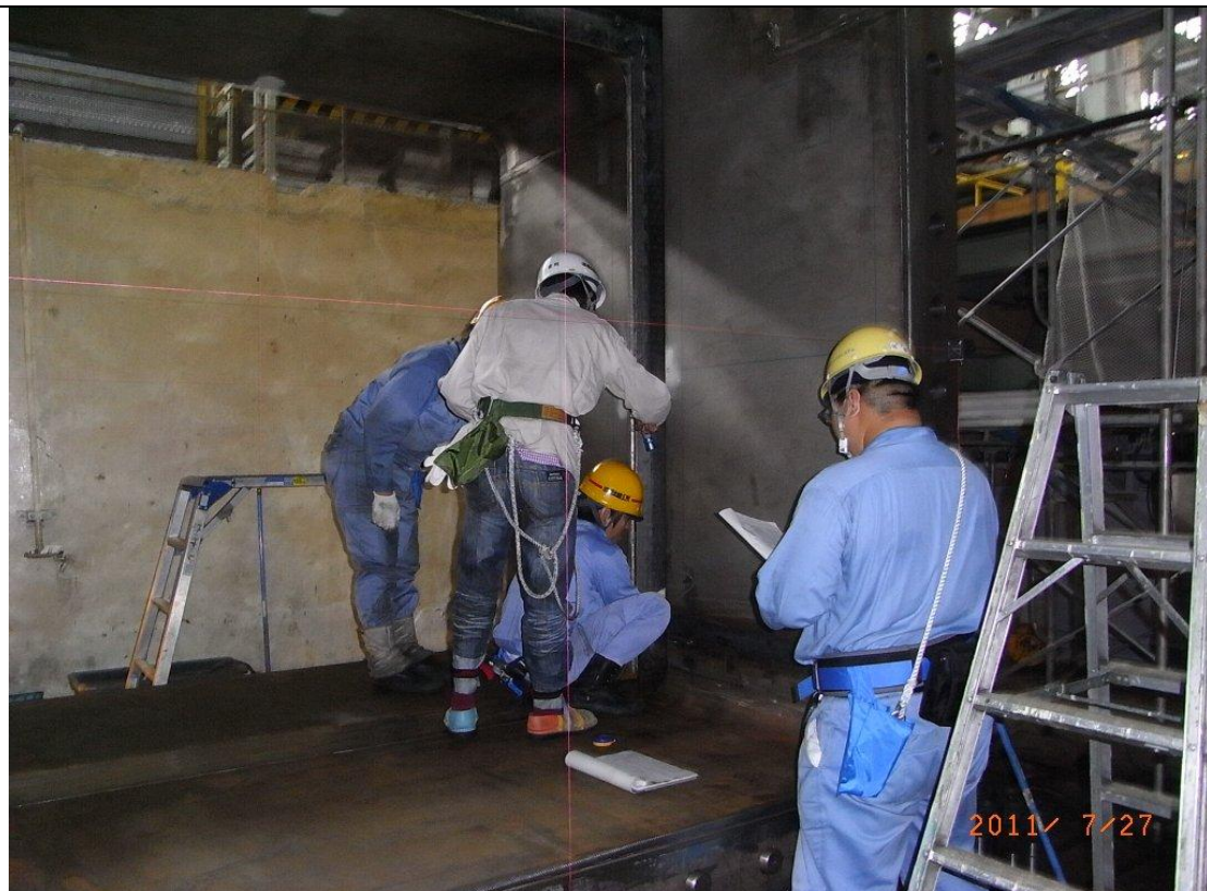
07/27 No.2 高壓滑動閘門尺寸及外觀檢查
