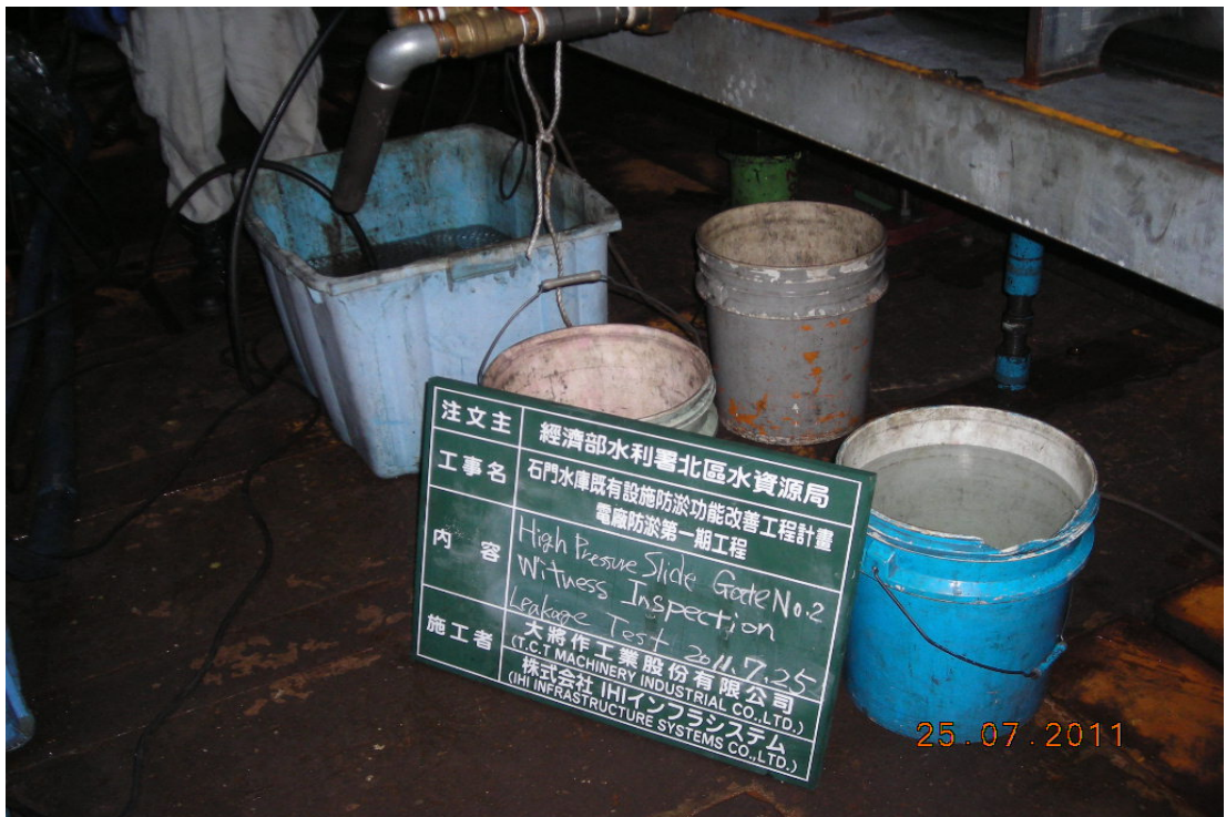
7/25 No.2 高壓滑動閘門漏水試驗，測試條件:1.37Mpa 持續 10 分鐘
