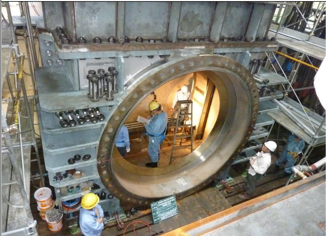
07/26 No.2 射流閘門尺寸及外觀檢查
