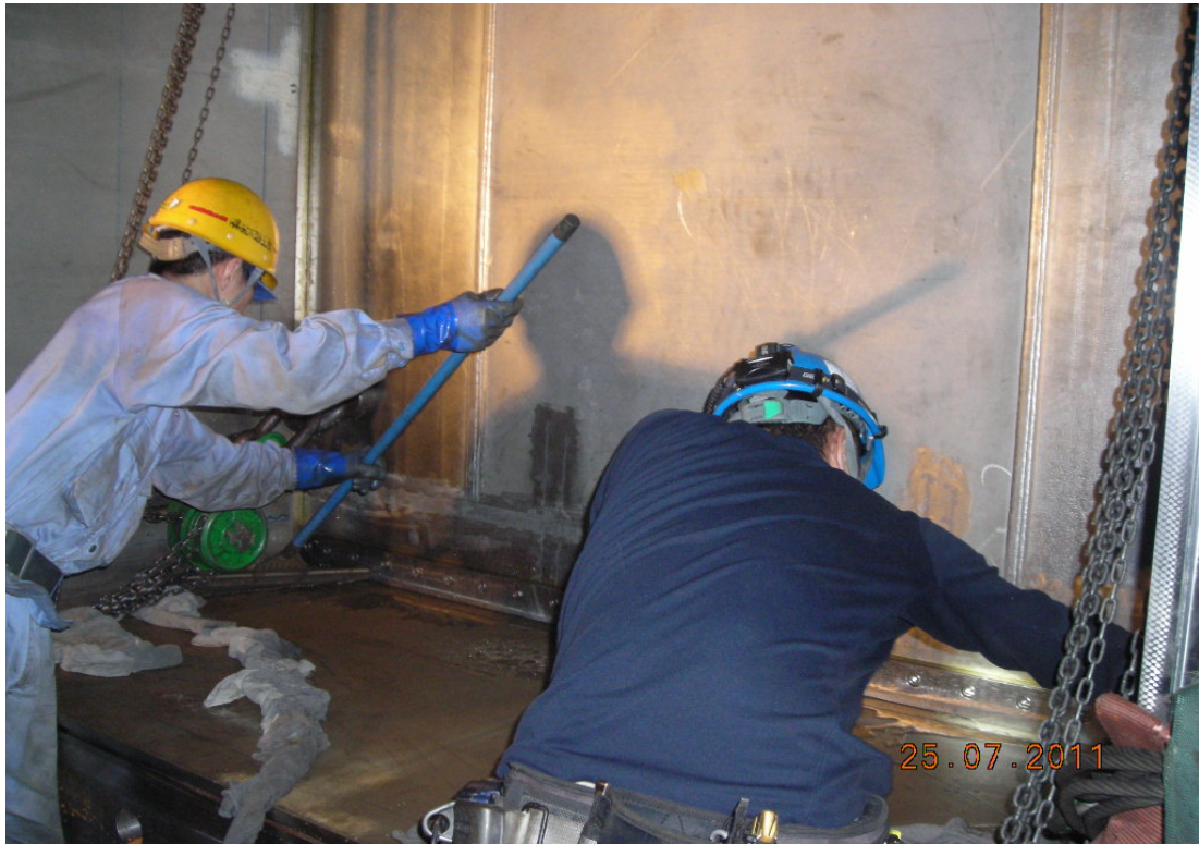
7/25 No.2 高壓滑動閘門漏水試驗，收集漏水量，測試結果 1,211CC/分 << 標準 3,360CC/分，測試結果符合
