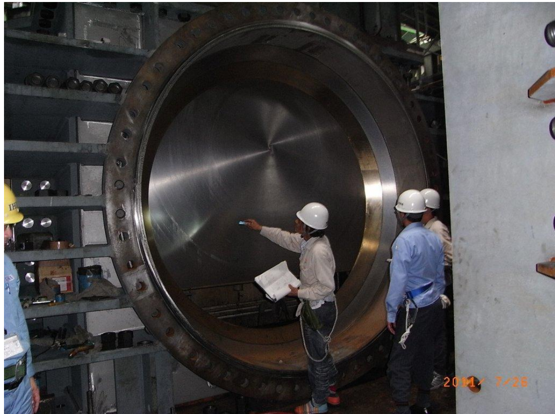
07/26 No.2 射流閘門尺寸及外觀檢查
