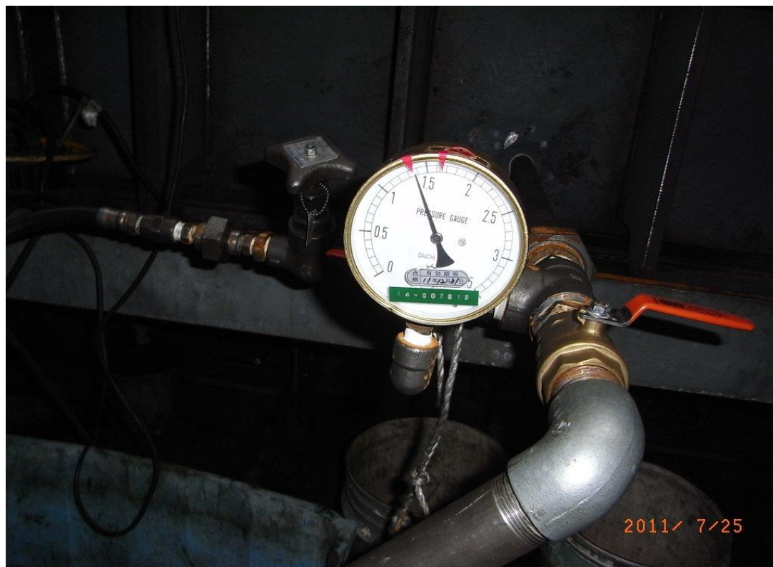
No.2 高壓滑動閘門試漏，測試過程由於有輕微滲漏致使測試壓力下降至 1.32MPa 略低於標準壓力，經當場向 IIS 反映並要求加壓後重測，測試結果漏水量符合標準
