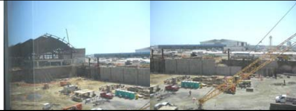
國際航廈擴建工程 -3
