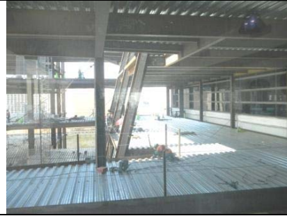
國際航廈擴建工程 -2
