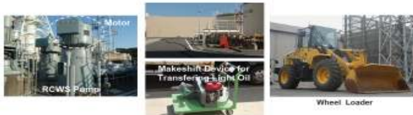
圖15 緊急海水泵浦馬達失效而喪失海水冷卻狀況之因應
