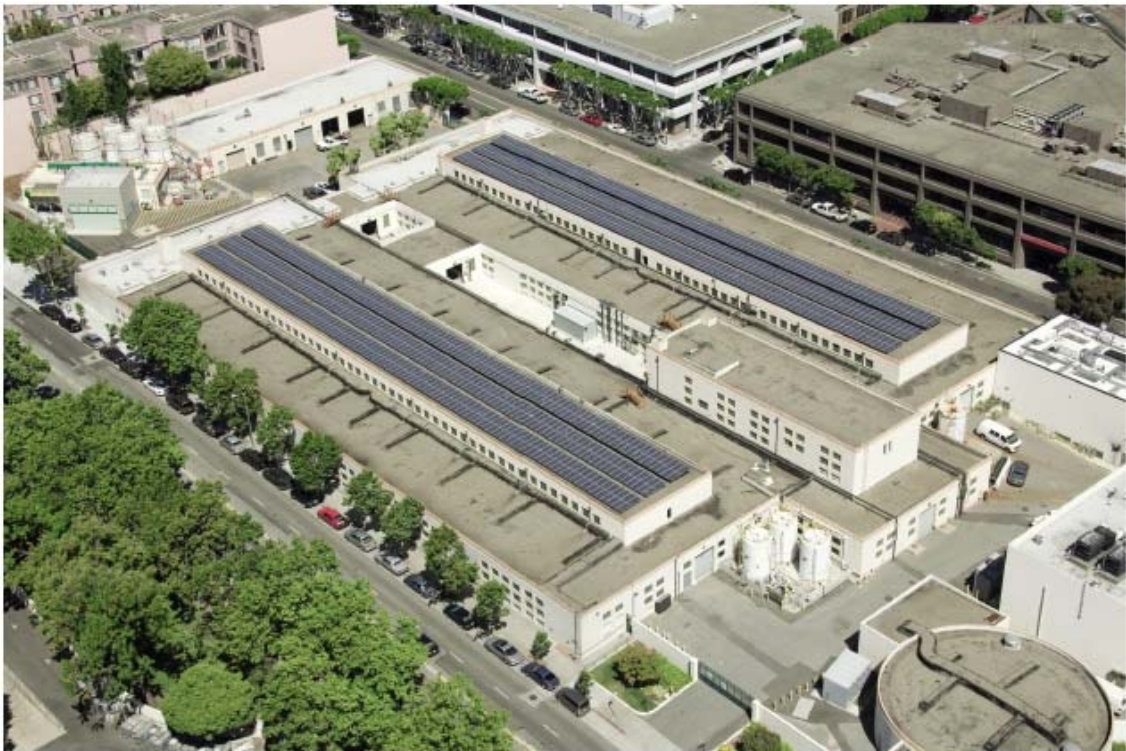
圖 4.6.1 太陽電池實際上裝設情形
