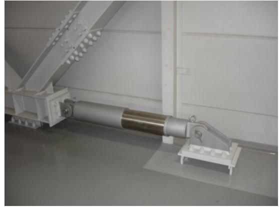
照片 7 FUJITA 公司試驗室減震設計(二)
