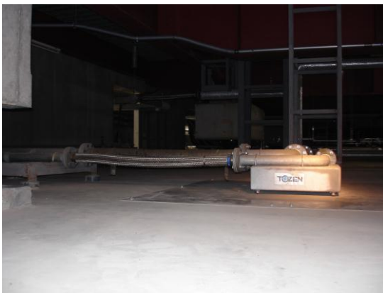
照片 6 FUJITA 公司試驗室減震設計(一)
