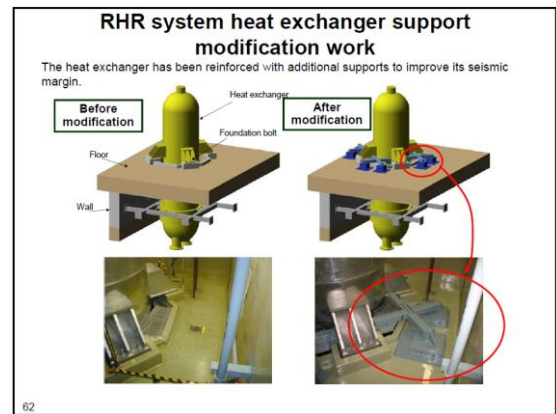
圖 13 RHR 熱交換器支撐補強
