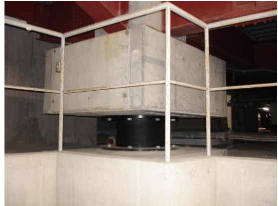
照片 7 FUJITA 公司試驗室減震設計(二)
