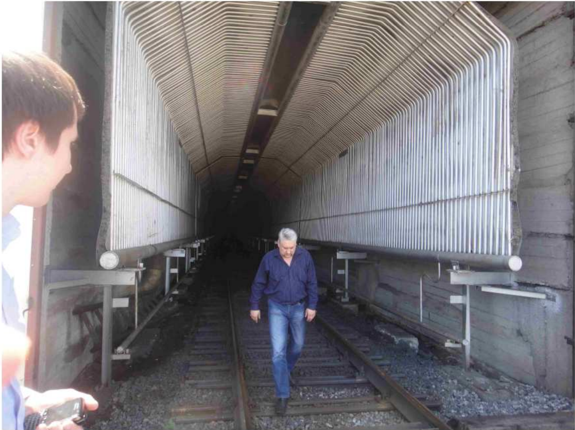
圖2-10 Vostochny港火車車廂加熱線圈
