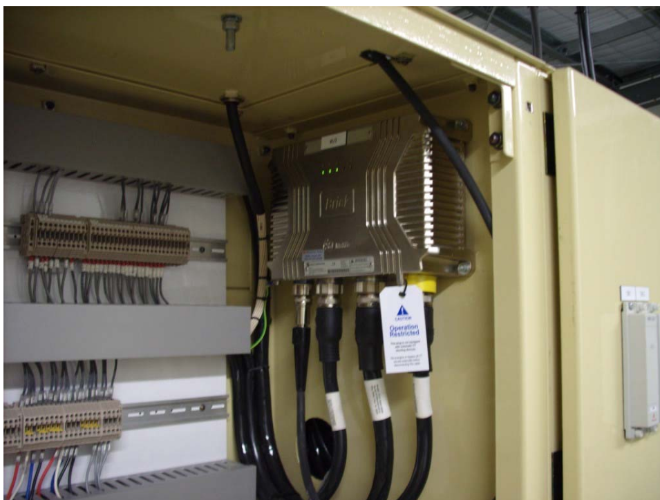
現場 Brick 安裝實況
