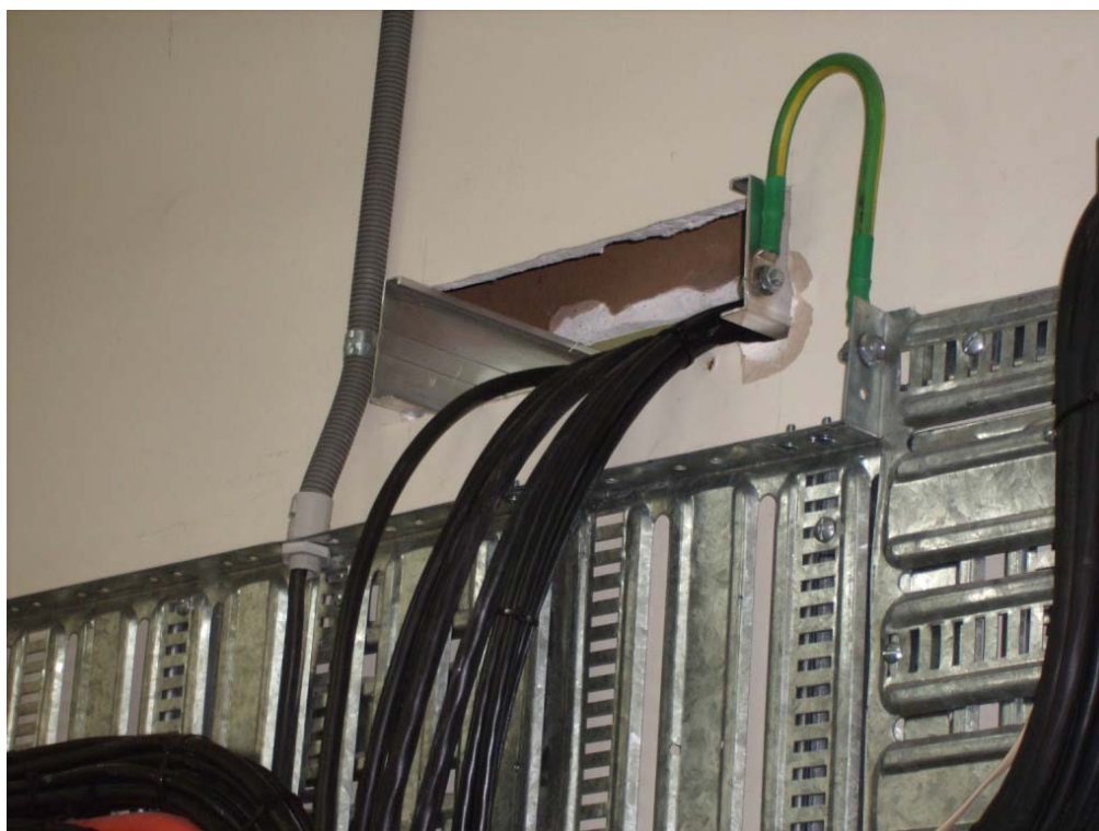
開關場至控制室僅需少數幾條光纜(無金屬電纜)
