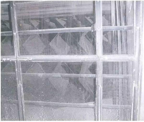
既有粗灰阻絕設備結構及柵網被粗灰破壞情形
