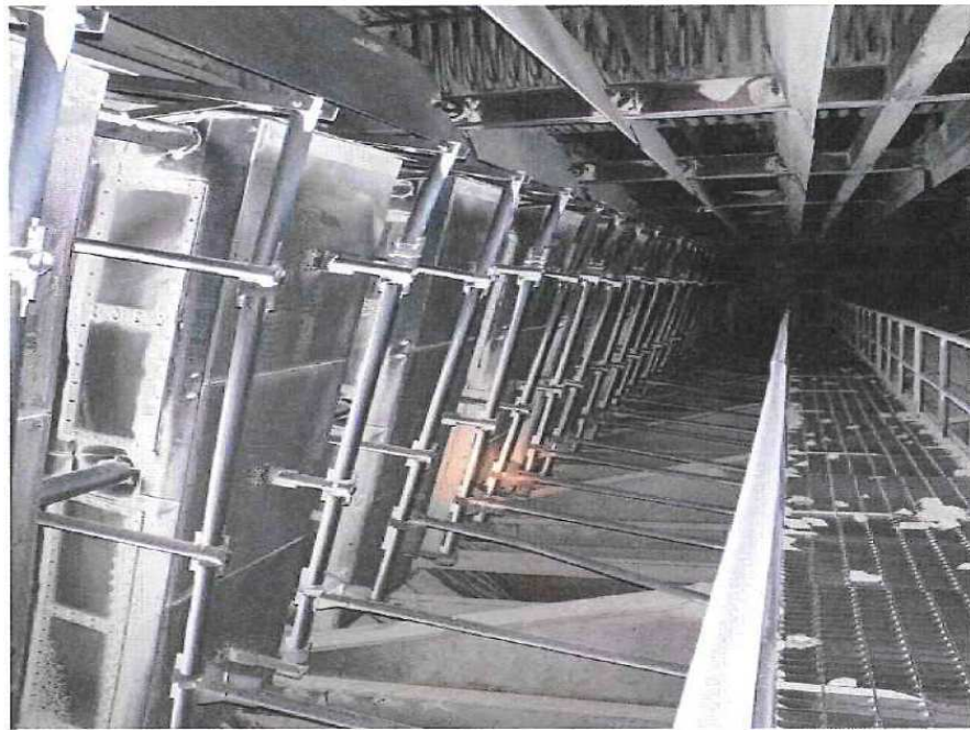
改善後粗灰阻絕設備結構
