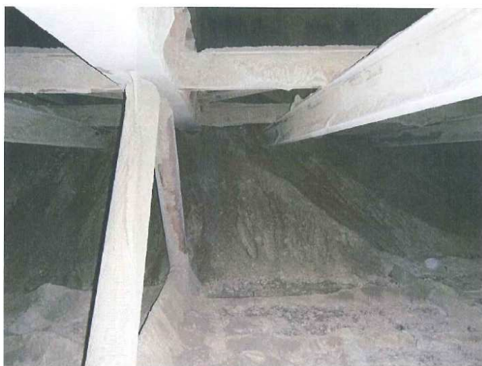
大量粗灰阻塞 SCR 設備情況
