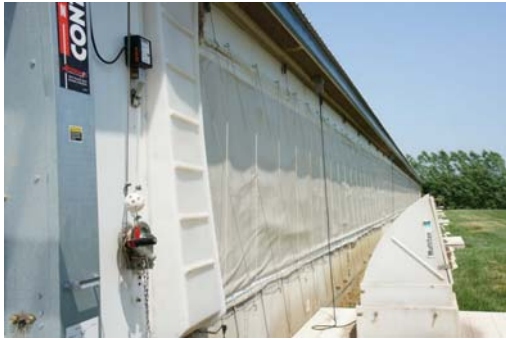
圖 17、豬舍外帆布升降控制設施及通風設施
