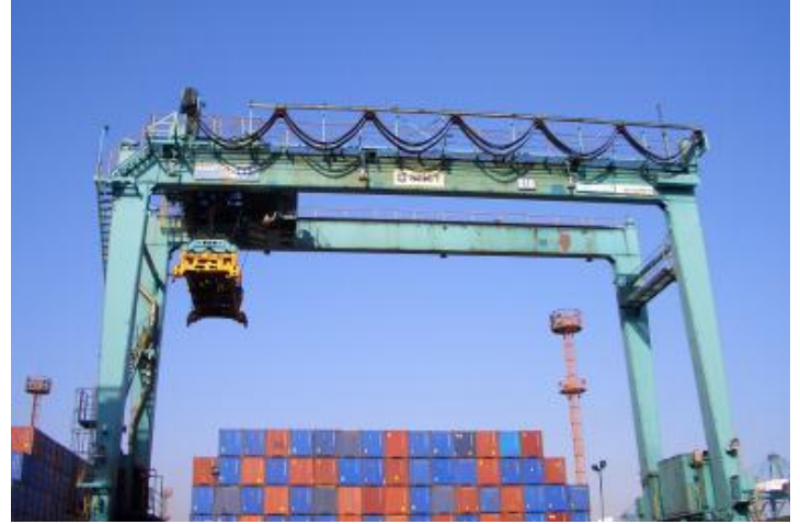
Container Crane 轮胎吊
