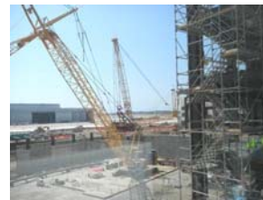
國際航廈擴建工程-4
