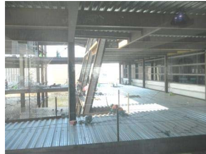
國際航廈擴建工程-2
