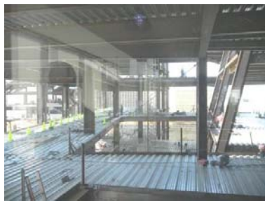
國際航廈擴建工程-1
