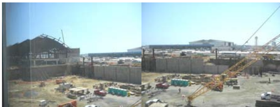
國際航廈擴建工程-3
