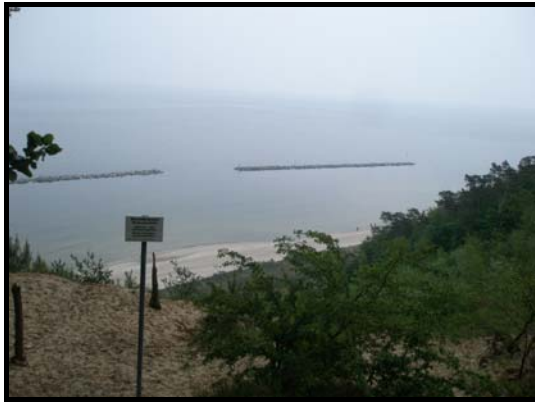
以離岸堤工法進行海岸防護
