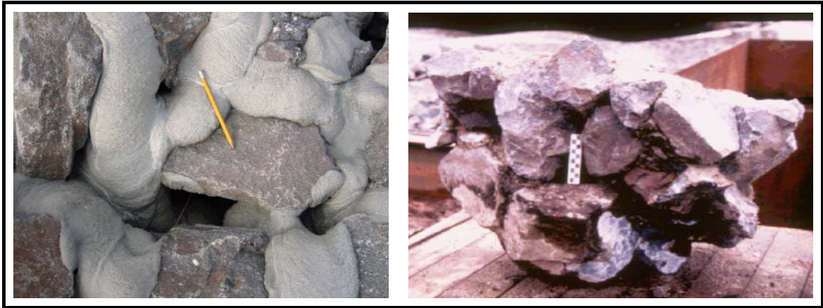
圖 3-11 部分灌漿拋石護層施作方式
