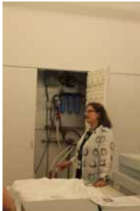
濾水設備等管線隱藏於牆內
