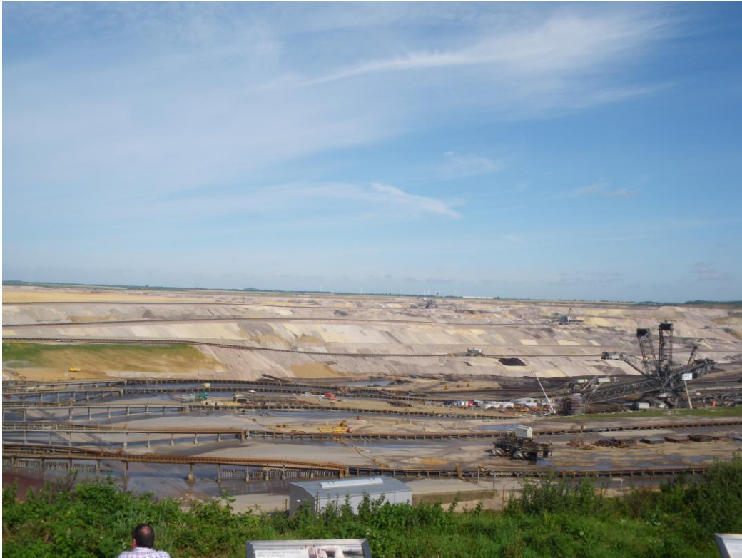
照片 10 Inden 煤礦露天採煤階段佈置-後方為表土堆置與整復。
