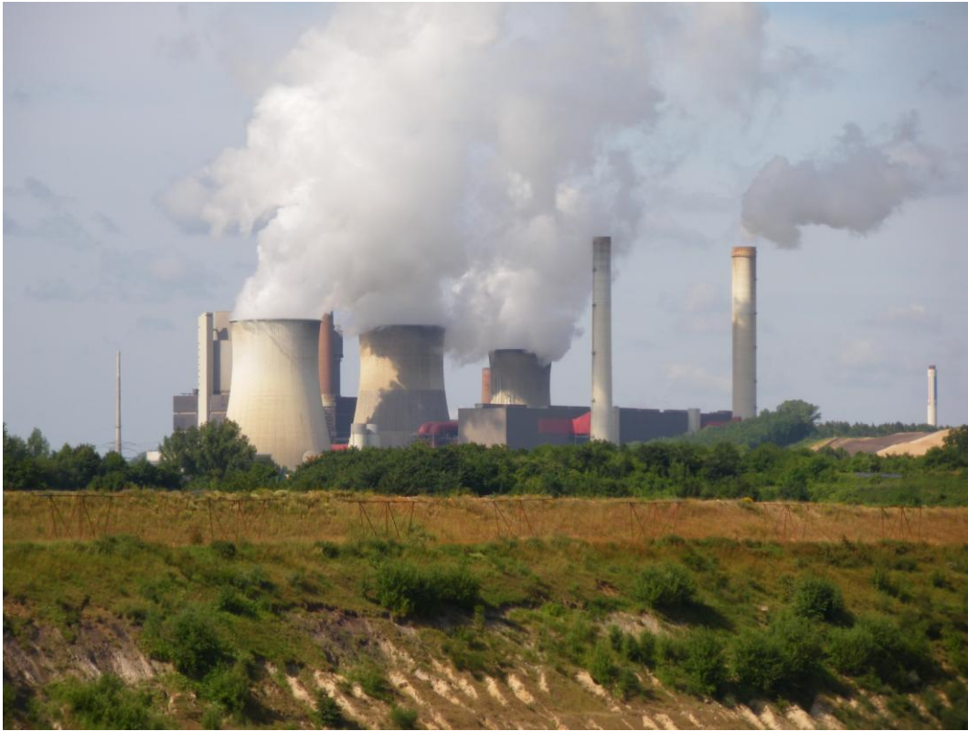
照片 6 RWE 能源公司位於礦區旁以褐煤燃料之火力發電廠
