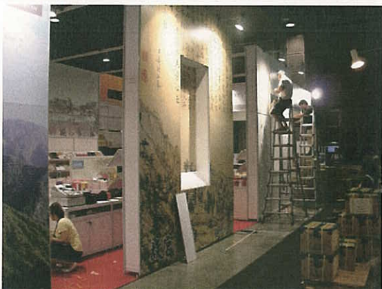
圖七：施工中之主題牆
