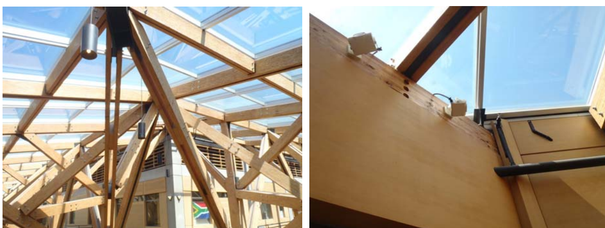
圖15、在集成樑上裝設的監測器材
