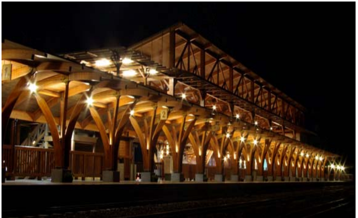
圖20、國內的新阿里山車站建築也是使用Glulam作為主要的木質材料
