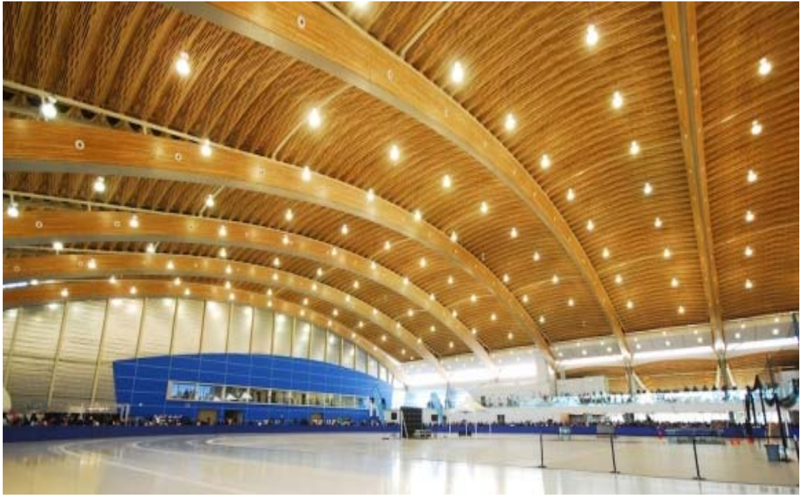
圖19、Richmond Oval滑冰場使用膠集成材Glulam與鋼材混合，創造出世界上最長的淨跨距樑拱的木構造建築
