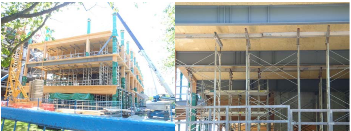
圖18、UBC大學內一座興建中使用膠合集成材Glulam與鋼材的混合木構造建築
