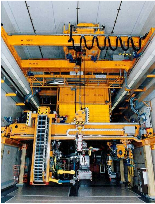
圖十六、德國 WAK 遙控拆除主要吊車
