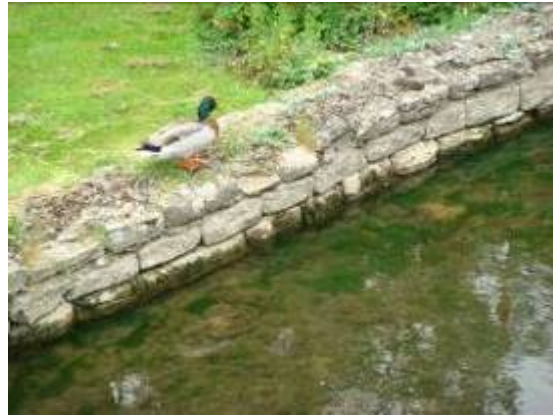
左： 水上柏頓莊園 砌牆放大（仔細觀察接縫並無黏縫劑） 右： 比柏利 水岸護堤砌石
