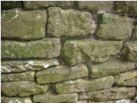
左： 水上柏頓莊園 砌牆放大（仔細觀察接縫並無黏縫劑） 右： 比柏利 水岸護堤砌石
