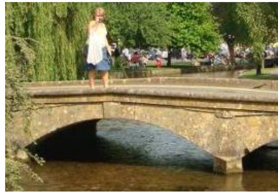
船頭型橋墩減少水流阻力（左：契斯特 Chester，右：科茲窩水上柏頓 Courton-On-the-Water）
