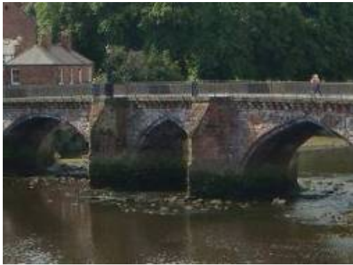
船頭型橋墩減少水流阻力（左：契斯特 Chester，右：科茲窩水上柏頓 Courton-On-the-Water）
