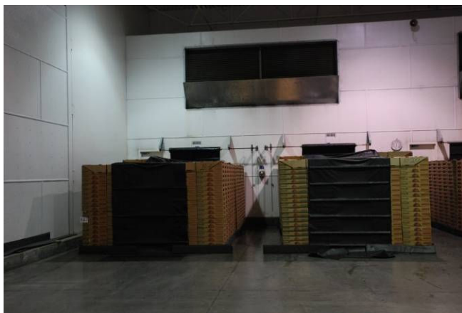
圖 8. 壓差預冷由風扇對產品抽氣後，空氣再從上方風口送出，形成循環。
