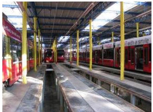
圖 164. 輕軌電車維修廠－維修走道
