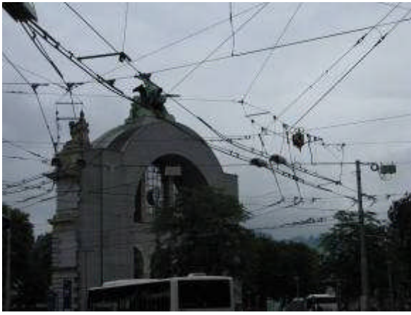
圖 167. 輕軌電車纜線與景觀衝突
