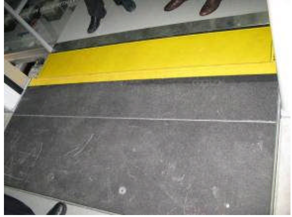
圖 20. 月台間隙延伸板與電車殘障門接軌
