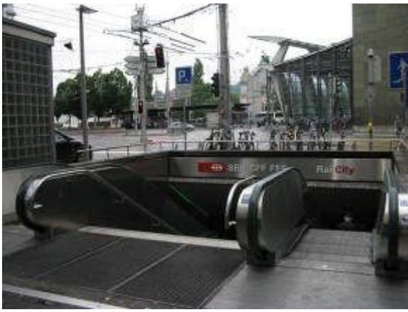
圖 119. 無遮雨棚電梯出入口
