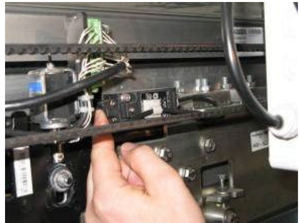
圖 55. 極限(微動)開關裝置動作測試
