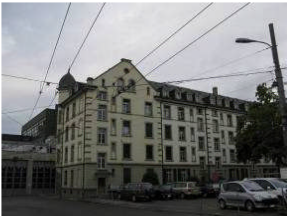
圖 171. 輕軌電車纜線與景觀衝突
