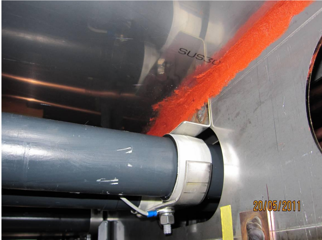
照片 23. 車底配管、配線製程實況
