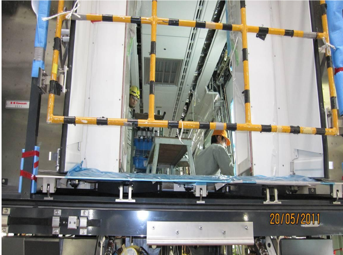
照片 25. 車內配管、配線製程實況
