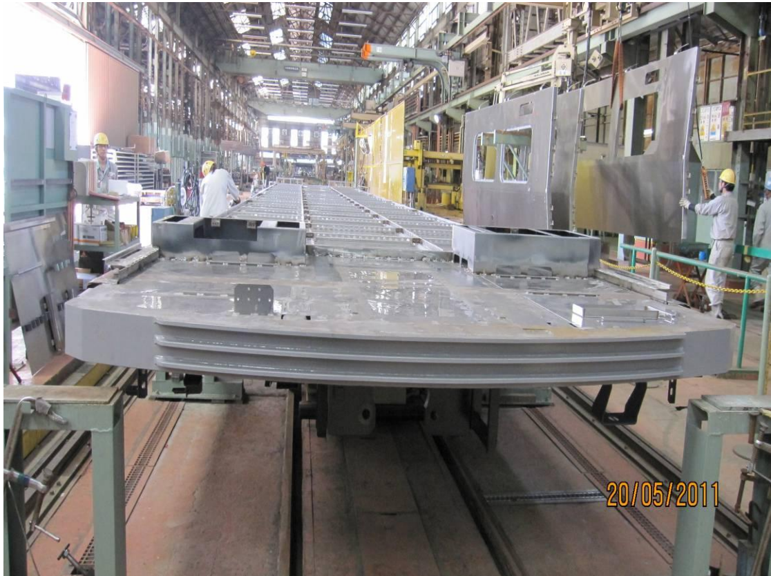
照片 11. 車廂側牆吊裝製程實況
