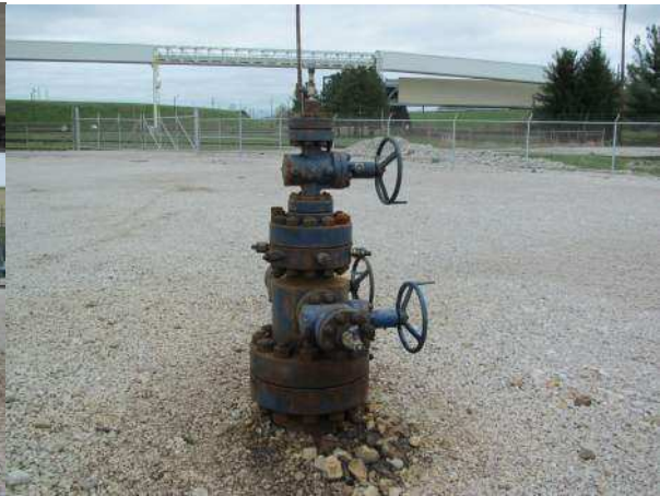
圖 52 注入井附近之監測井(MW3)
