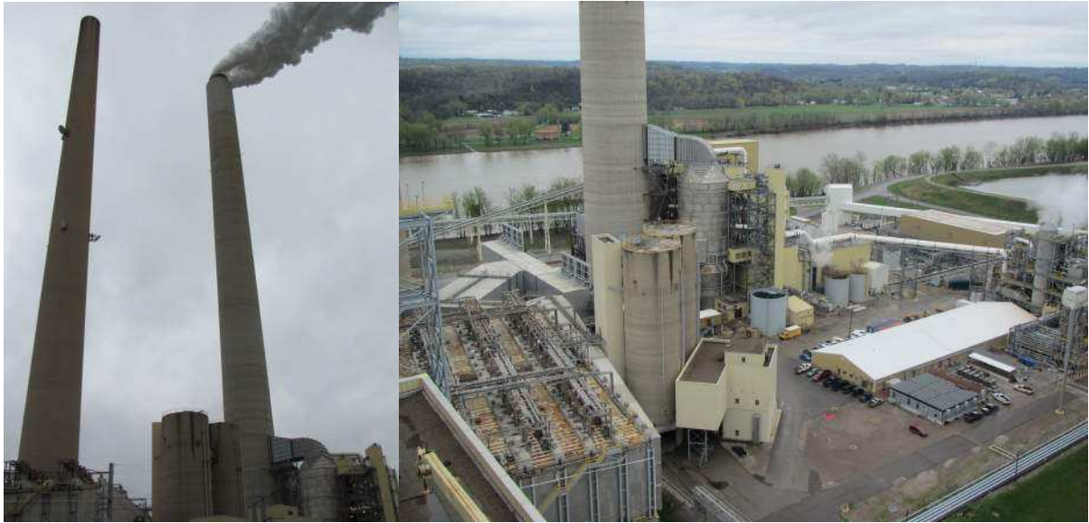
圖45 Mountaineer CCS計畫係由煙道引流煙氣至FGD再進一步作二氧化碳捕獲
